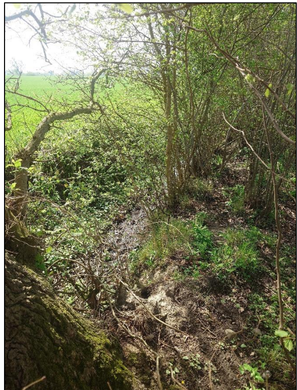
Abbildung 8: Graben E (Foto: Planungsbüro ALSE, 24.04.2025)
